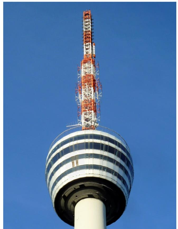
*Bild 4, oben: SWR Fernsehturm Stuttgart mit KATHREIN Sendeantennenanlage (8 UHF Antennen Felder, zirkular polarisiert)*
