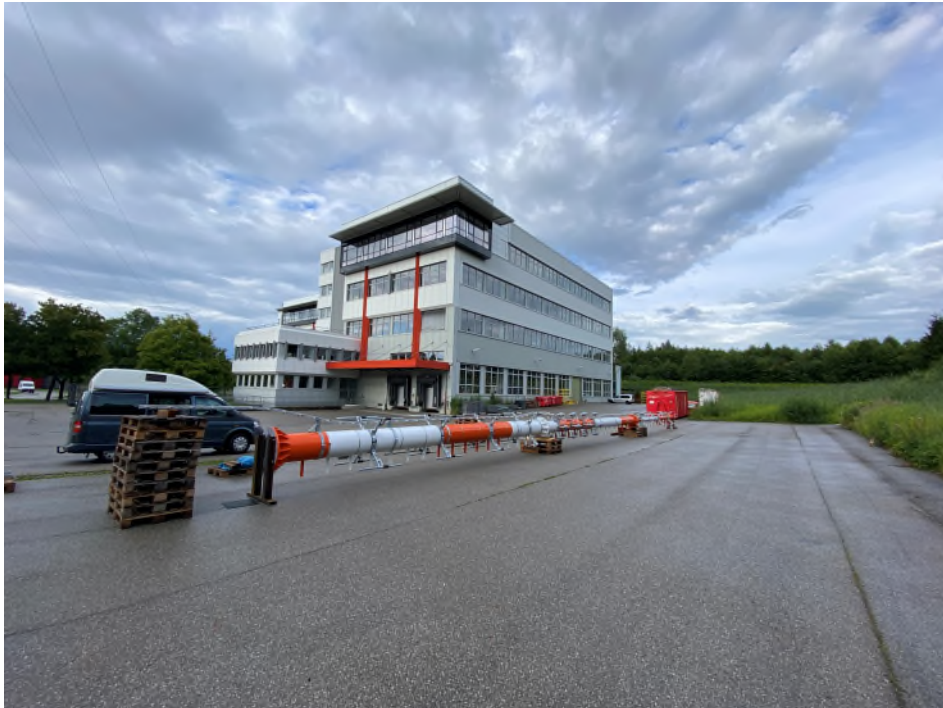
Endmontage der 26 Meter langen Antenne im Hof
