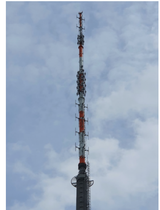
Die Antenne nach der Montage am Standort
