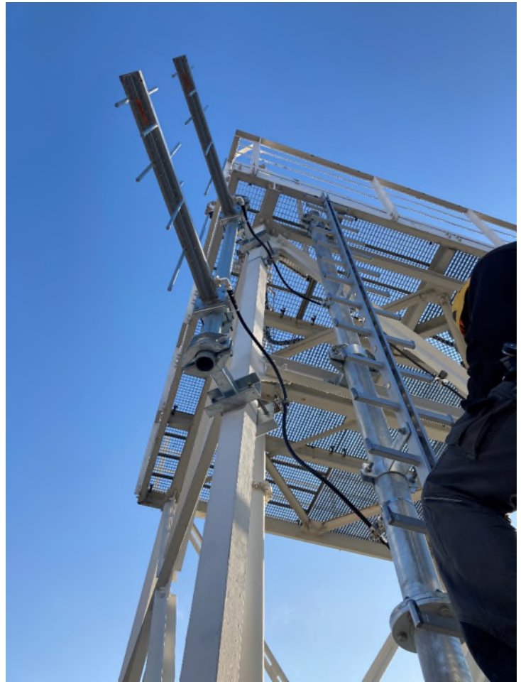
Bild 1, oben: 2 vertikal polarisierte KATHREIN Log. Per. Antennen sorgen für DAB+ Empfang
